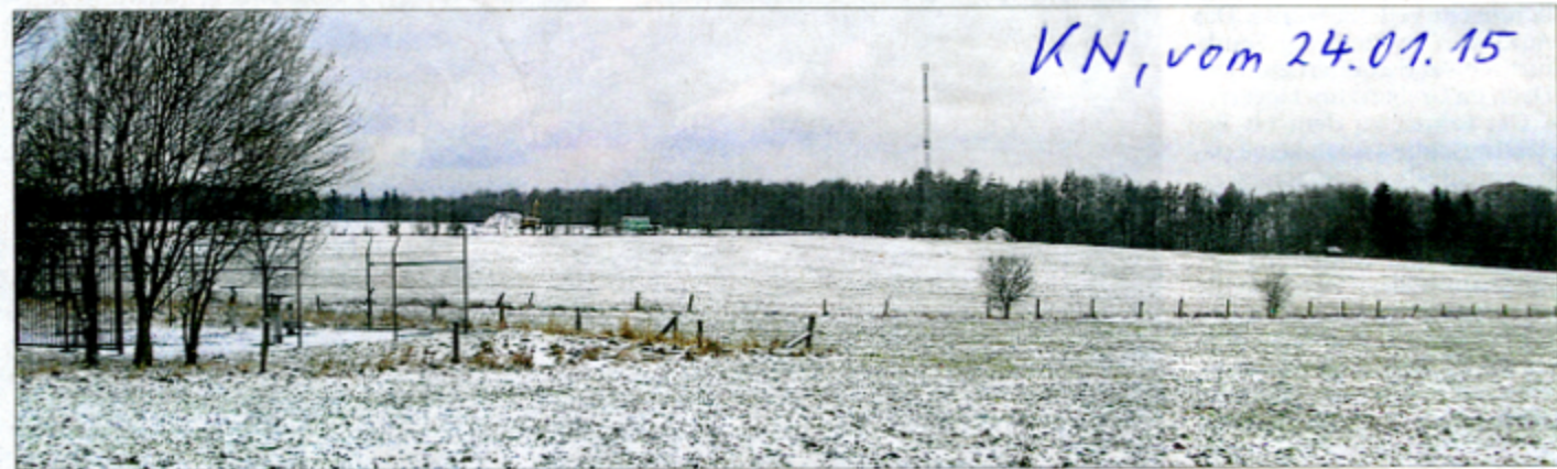
Die Flur Wilder Stein bei Wallroth. Links ist die Gasschieberstation zu sehen, hinten ein Mobilfunkmast. Foto: Bernd Ullrich
